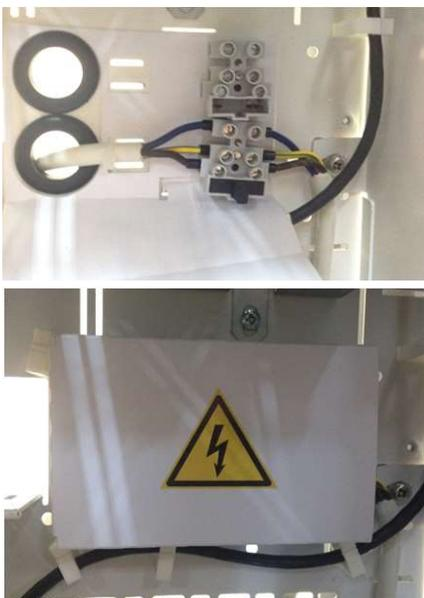
Les câbles secteur doivent être à double isolation. Les maintenir par un collier d'anti-arrachement (repère. 1a et 1b) fixé sur un des pontets situé dans le fond du coffret.
