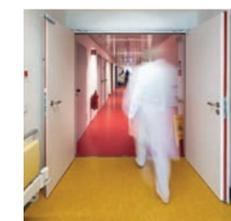
L'efficacité du désenfumage mécanique est liée au respect du calcul du volume à désenfumer. Les portes résistantes au feu maintenues ouvertes doivent se fermer pour reconstituer le volume initialement calculé.
